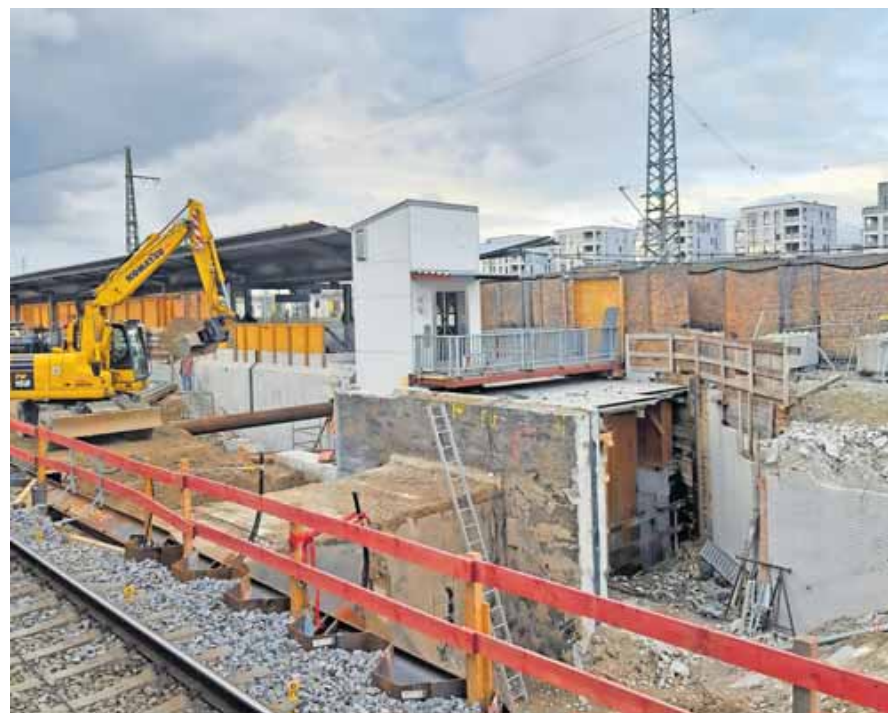
Den Interimsaufzug hatte die Bahn 2021 in Betrieb genommen, damit der Bahnhof auch während der Bauarbeiten barrierefrei zugänglich bleibt. FOTO: DEUTSCHE BAHN
